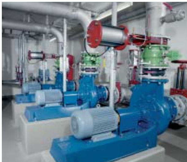
Prozesspumpen, horizontal auf einer Grundplatte für schnellen Service montiert
